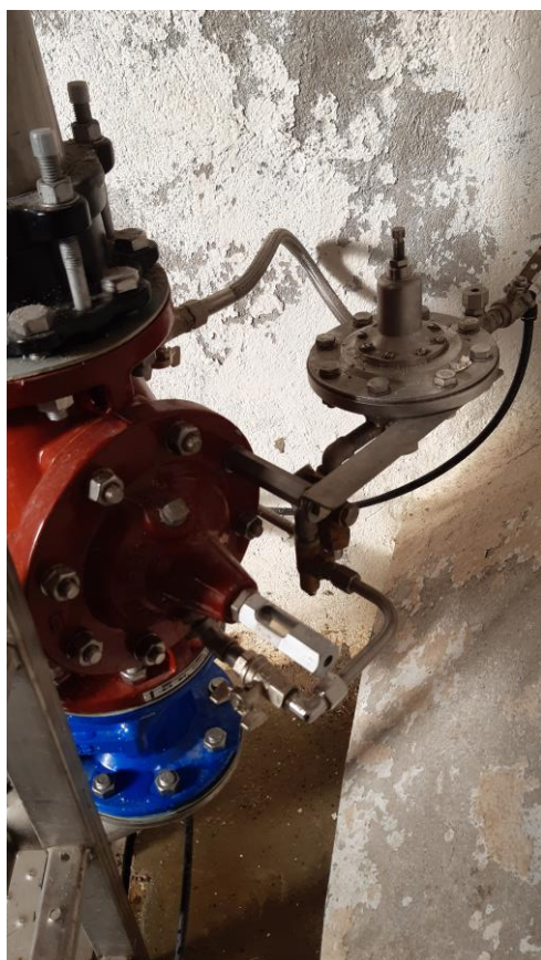
Réservoir d'Orgemont Robinet altimétrique du secours arrivant de la Bonnasse
