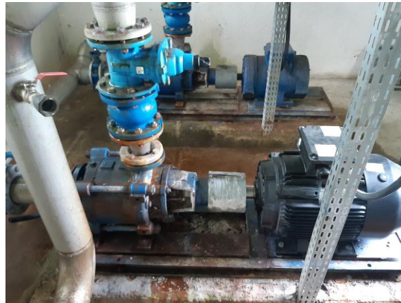
Pompage Echelles – Bornachon Avant rénovation
