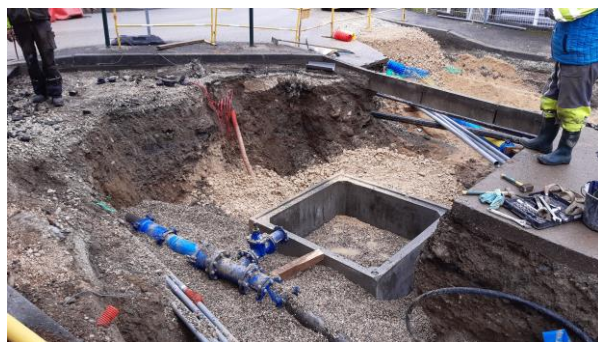
Renouvellement RD908b (Sillingy)
