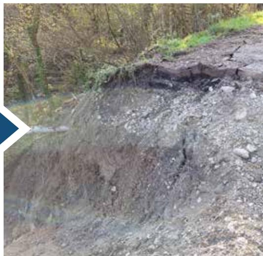
Afin de rouvrir la route à la circulation, plus de 250 m<sup>3</sup> de décombres ont dû être évacués à l'aide d'une pelle araignée et d'une grue.
