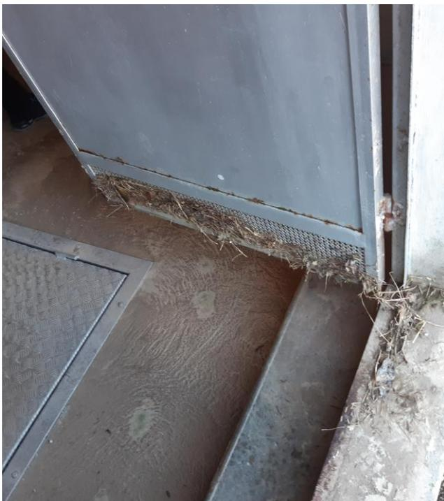
*Laisses de crue et boue à l'entrée de la station de pompage de Nangerat*
