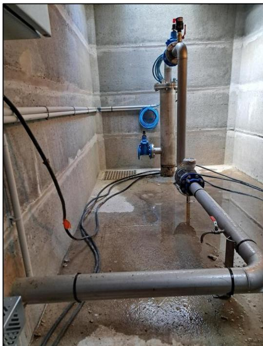
Suite aux essais de pompage et de rabattement de nappe concluants réalisés en 2022 sur le site de forage potentiel dans le quartier des Combes, à Sillingy, ainsi que l'aménagement fin 2023 d'un regard en tête d'installation permettant sa sécurisation et sa mise au sec, la CCFU a pu démarrer au mois de juin 2024 son protocole de tests qualité sur l'eau brute.
