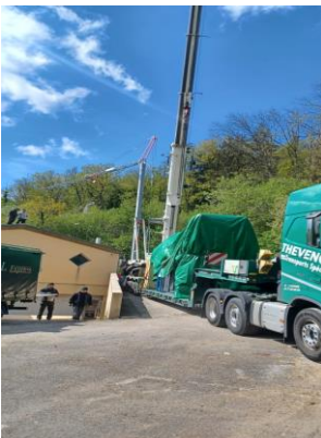
Utilisation d'un camion grue de 20 tonnes
