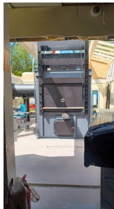
Mise en place du four après dépose de la toiture
