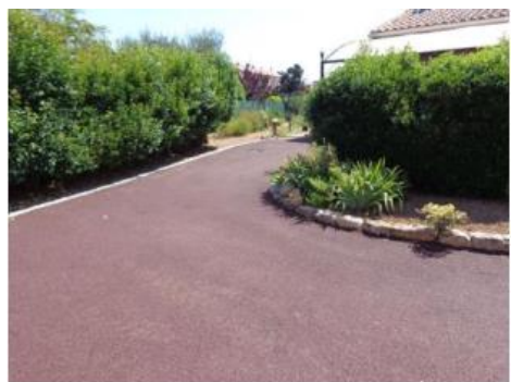
Allée/parking en enrobé poreux (source : Celtivia)
