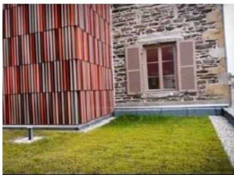
Toiture végétalisée (source : Grand Lyon)
